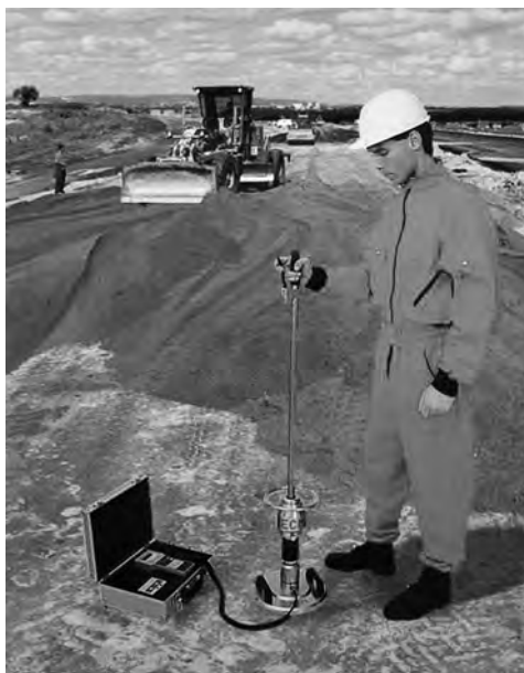
Obr. 4.45 Provádění lehké zatěžovací zkoušky kruhovou deskou
