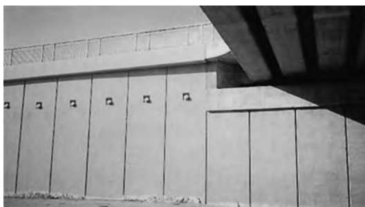
Obr. 5.50 Ukázka prefabrikované konstrukční stěny.
