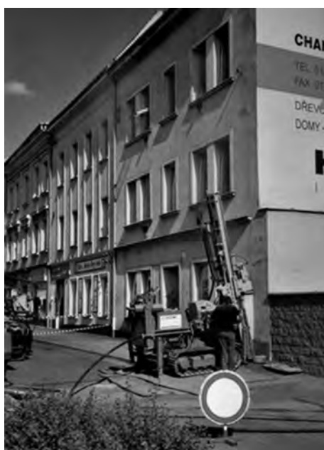
Obr. 5.105 Hloubení vrtů pro injektáž základů stavební konstrukce.
