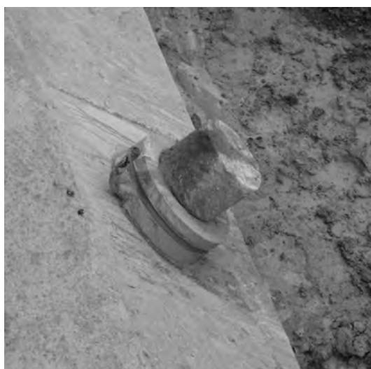
Obr. 5.74 Detail svěrné hlavice kotvy.
