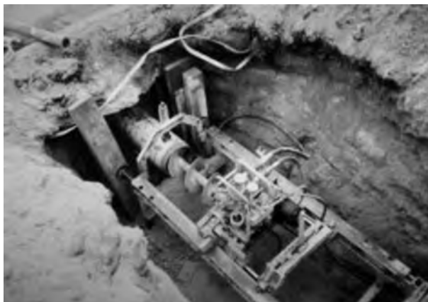
Obr. 5.139 Vrtná souprava Perforator PBA 20 v provozním nasazení.
