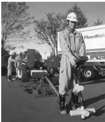
Obr. 5.159 Provádění povrchové kontroly směru pohybu vrtného nástroje.
