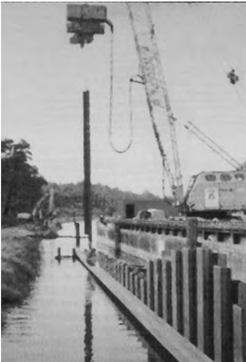
Obr. 5.41 Ukázka provádění ocelové štětové stěny beraněním.
