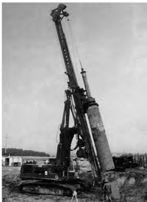
Vrtná souprava DELMAG RH 1413 při hloubení šikmých vrtů pro piloty.
