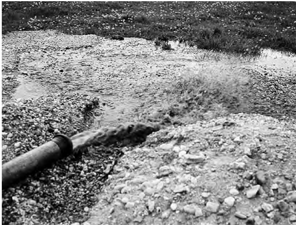
Obr. 3.21 Odvodňovací vrt při plnění své funkce.
