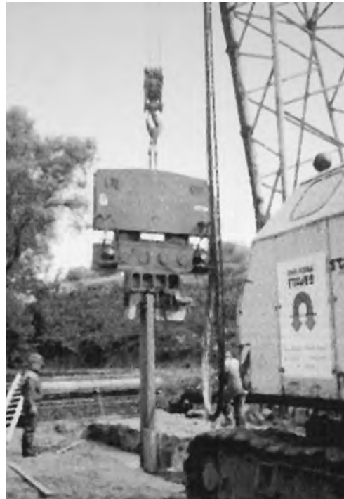
Obr. 5.42 Beranění štětových stěn pro regulaci potoka.
