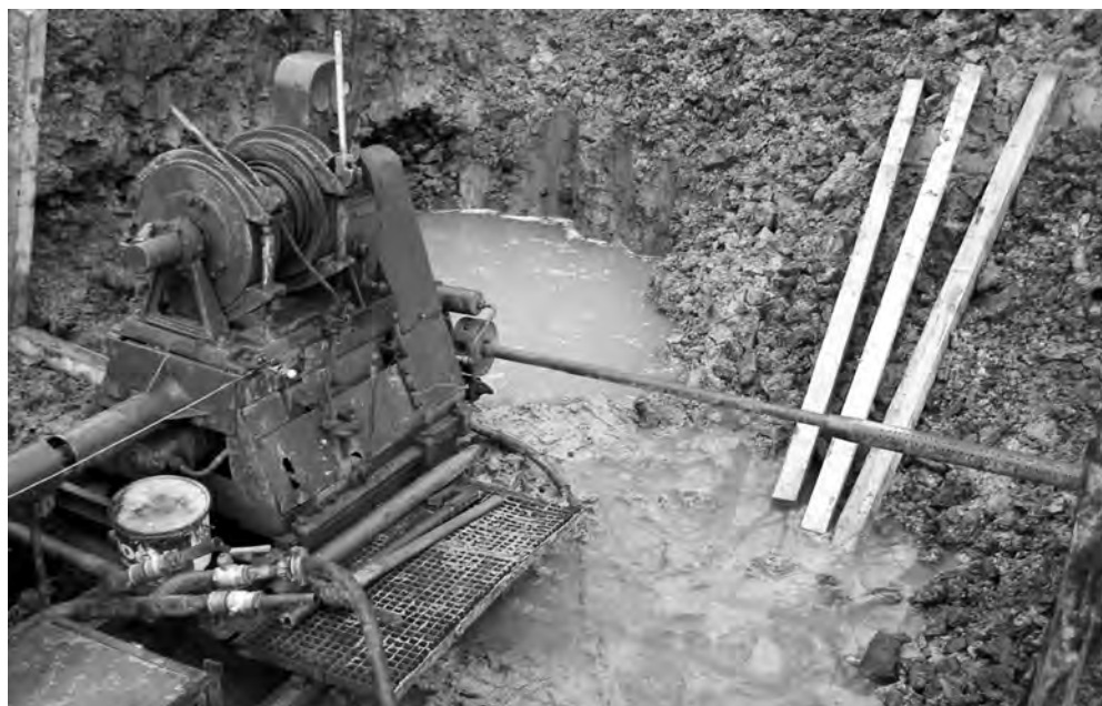
Obr. 3.18 Provádění horizontálního odvodňovacího vrtu vřetenovou jádrovou vrtnou soupravou.
