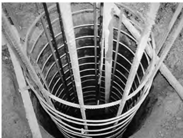
Obr. 5.29 Armokoš piloty osazený ve vrtu.
