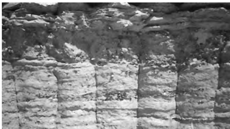
Obr. 5.113 Obnažená těsnící stěna provedená metodou jednosměrné tryskové injektáže.
