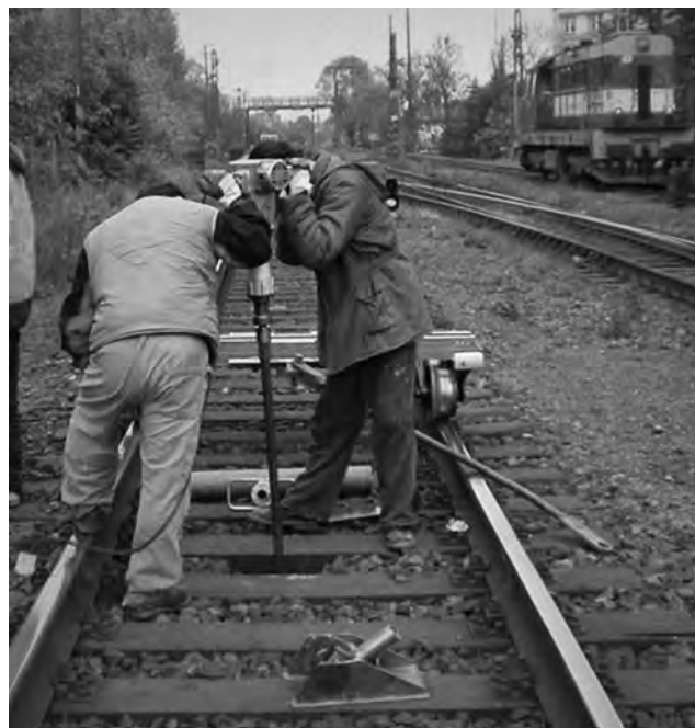
Obr. 4.16 Příklad použití vibračních sond.
