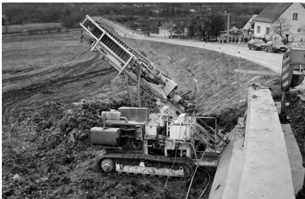
Obr. 5.61 Vrtání kotevních vrtů.
