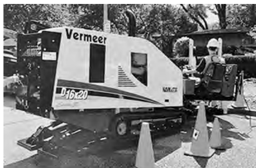
Obr. 5.160 Vrtná souprava typu Vermeer v provozní poloze při vrtání pilotního vrtu.
