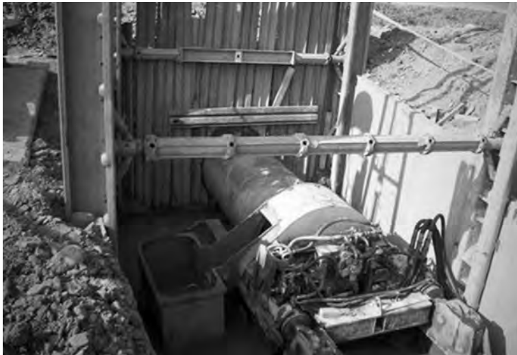
Obr. 5.143 Provozní realizace mikrotunelování s hydraulickou dopravou zeminy.
