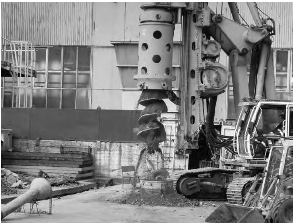
Obr. 5.25 Vrtání velkprůměrové piloty talířovým vrtákem.
