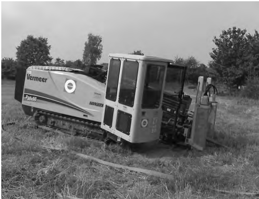
Obr. 5.162 Vrtná souprava typu Vermeer při rozšiřování vrtu přímo z povrchu.
