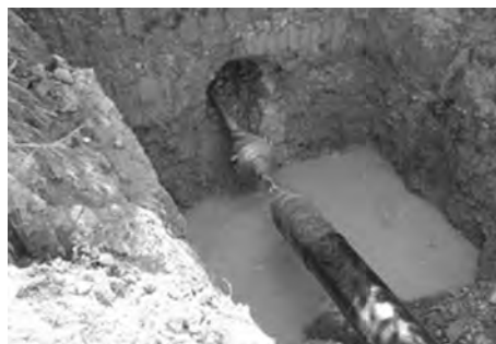
Obr. 5.163 Detail rozšiřovací hlavy se závěsem a zatahováním potrubím.
