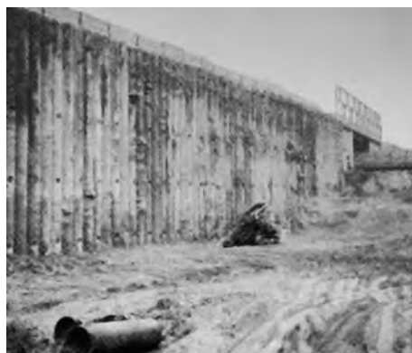
Obr. 5.45 Ukázka pilotové podzemní stěny.
