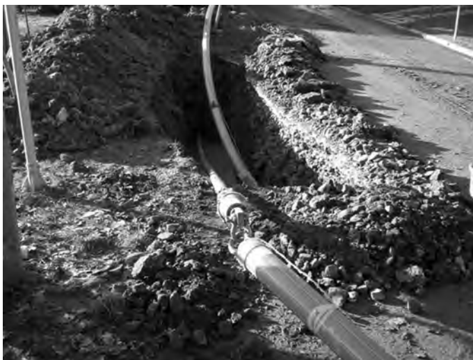
Obr. 5.158 Vrtné soutyčí s rozšiřovací hlavou ve spojení se zatahovaným potrubím v provozních podmínkách.
