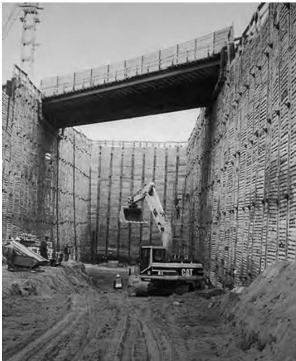
Obr. 5.43 Ukázka záporové podzemní stěny.
