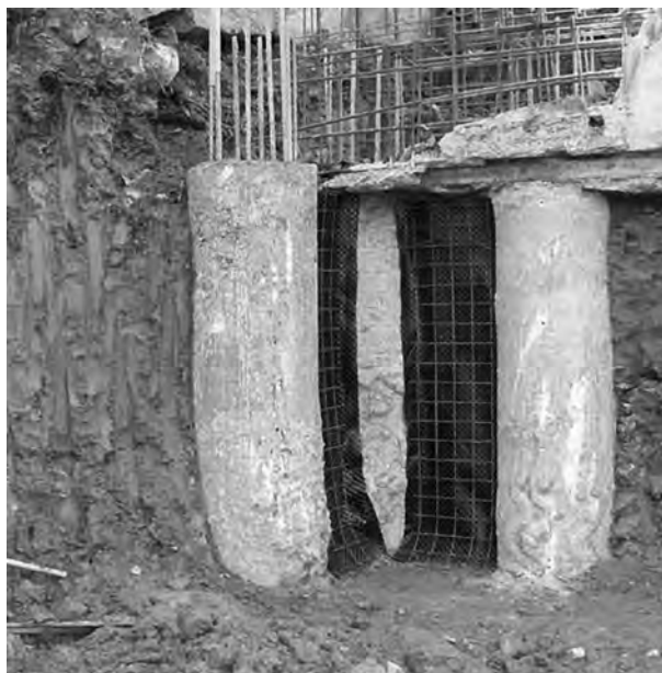
Obr. 5.30 Ukázka obnažené velkopřůměrové piloty.
