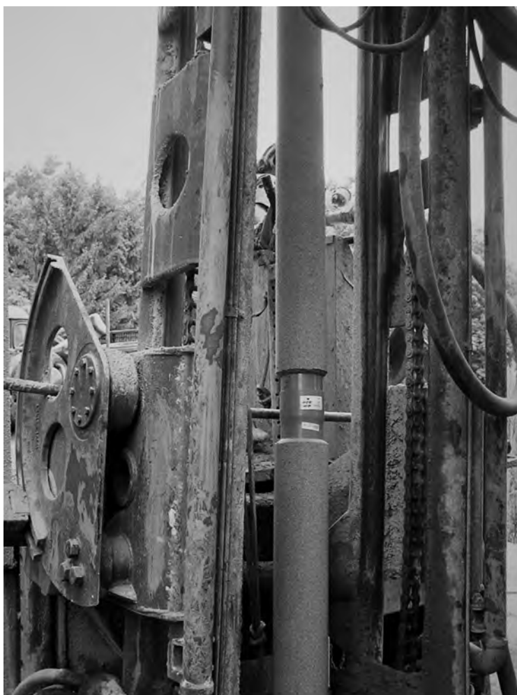
Obr. 3.12 Kolona filtrů s lepeným štěrskem ve věži vrtné soupravy při zapouštění do vrtu.
