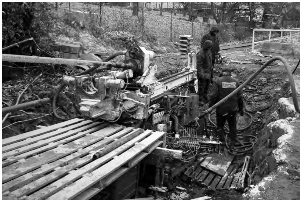
Obr. 3.17 Provádění horizontálního odvodňovacího vrtu lafetovou jádrovou vrtnou soupravou.
