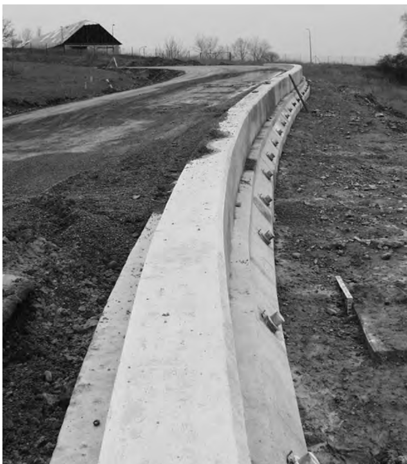
Obr. 5.73 Souvislá kotevní výztuž vozovky.
