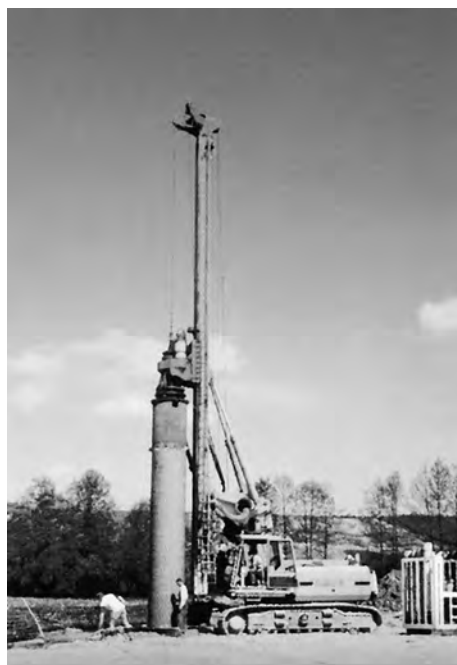
Obr. 5.32 Ukázka pažení vrtu pomocí posuvné rotační hlavy.
