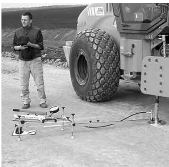
Obr. 4.43 Ukázka uspořádání měřicího zařízení při zatěžovací zkoušce kruhovou deskou.
