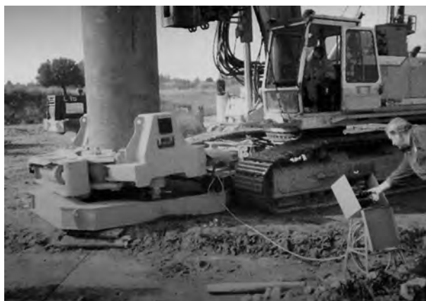
Obr. 5.34 Ukázka pažení vrtu pomocí pažícího zařízení.
