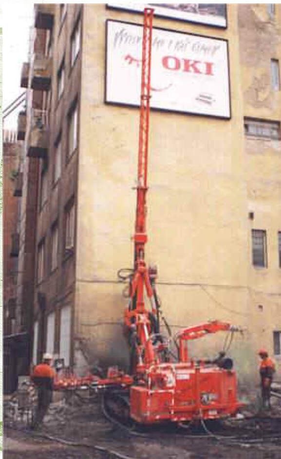
Příklad podchycování objektu pomocí mikropilot
