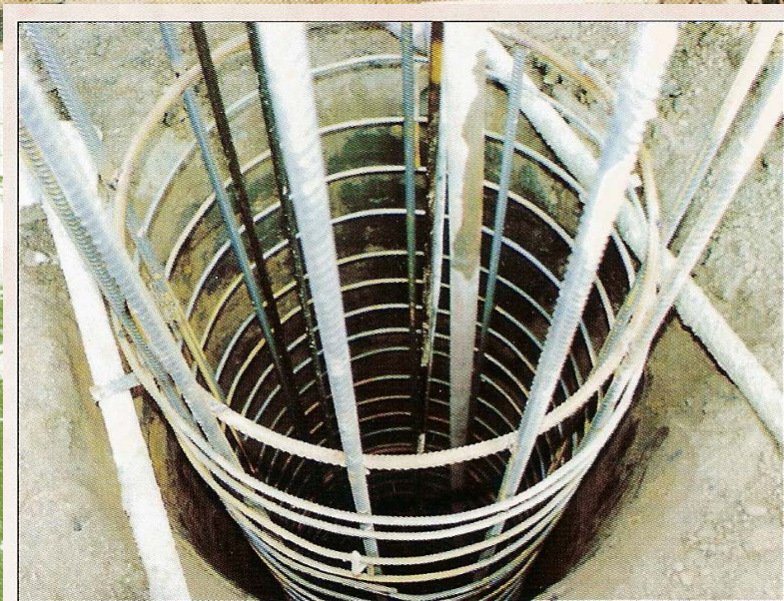
Armokoš piloty osazený ve vrtu
