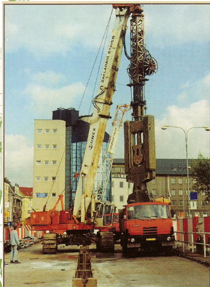
Těžba podzemní stěny
