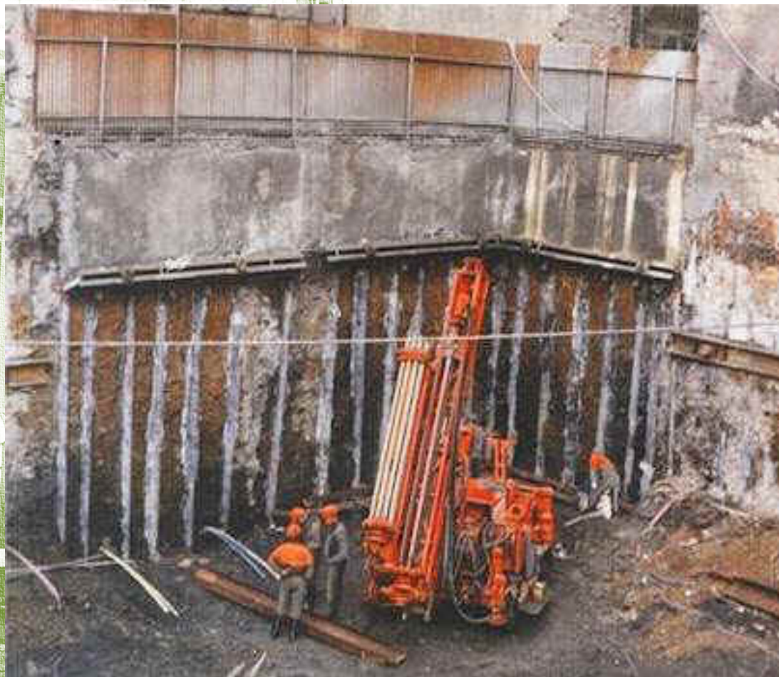
Příklad pažení stavební jámy mikropilotovou stěnou
