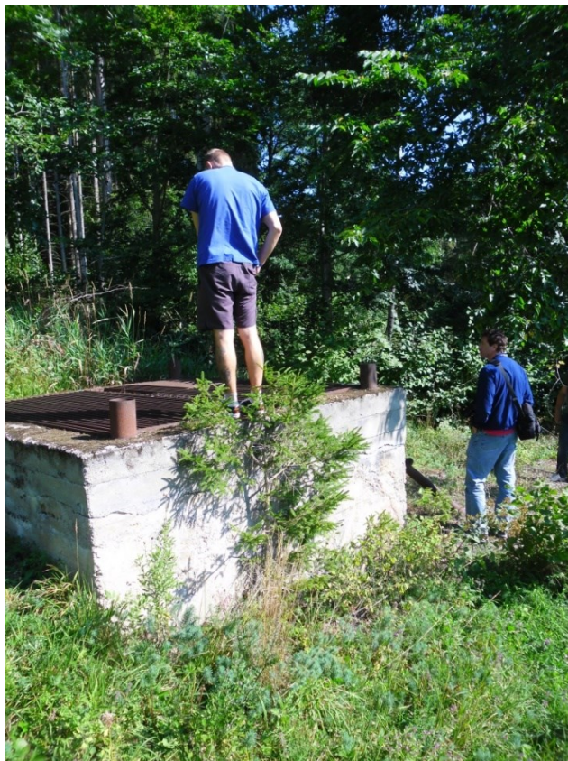
Obrázek 6 Vyústění vtažného komínu na povrchu, skutečný stav, 2017
